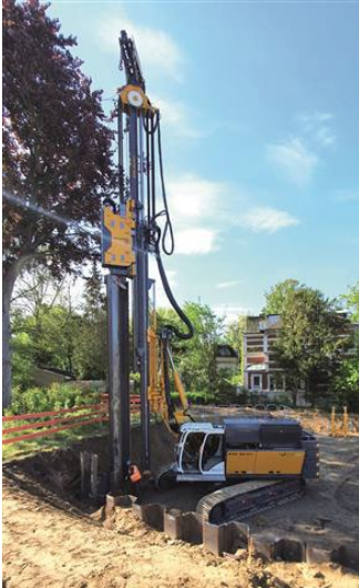
(1) RG 19T mit integriertem Spundbohlenassistent bei einem Projekt in Berlin
