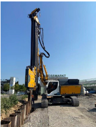
(2) RG 19T mit integriertem Spundbohlenassistent bei einem Projekt in Karlsruhe
