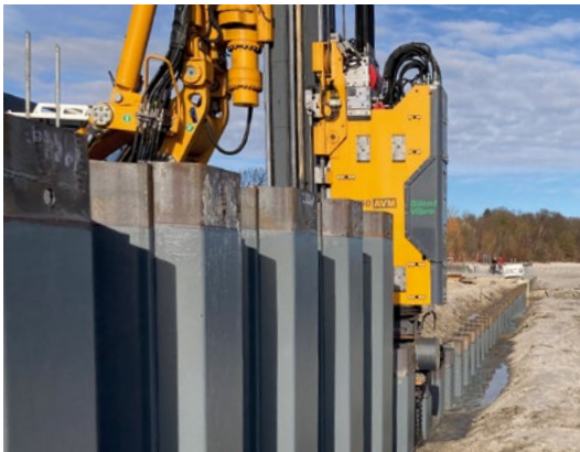
Rüttler mit ACS und SilentVibro Vibrator with ACS and SilentVibro
